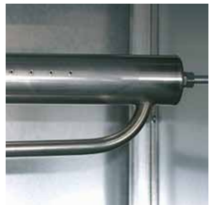
Dampfbefeuchterlanze mit Kondensatrohr
