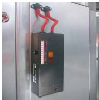
Differenzdruckmanometer (Filterüberwachung)
