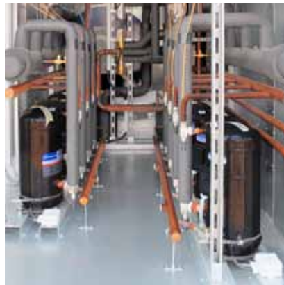
Direkte Kühlung mit Direktverdampfer
