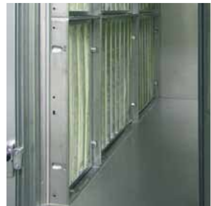
Filterrahmen fest eingebaut
