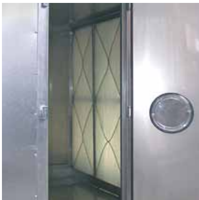
Tropfenabscheider für Hochdruckbefeuchter
