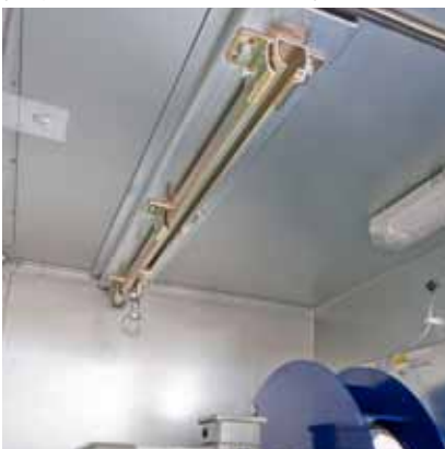
Auszugsschiene zum Ventilatortausch
