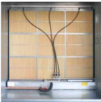
Kontaktbefeuchter mit drei Kaskaden
