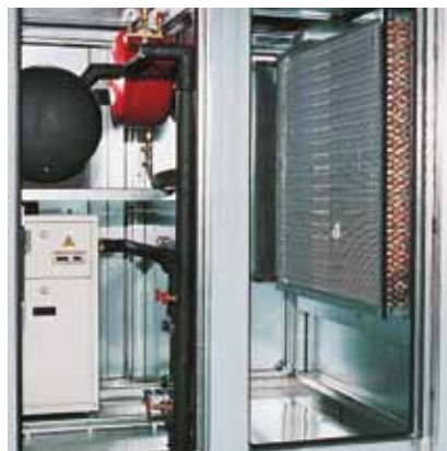
Indirekte Kühlung mit Kaltwassersatz
