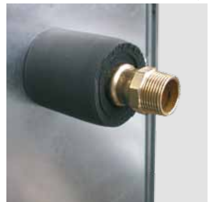
Wanddurchführung mit Armaflex-Isolierung
