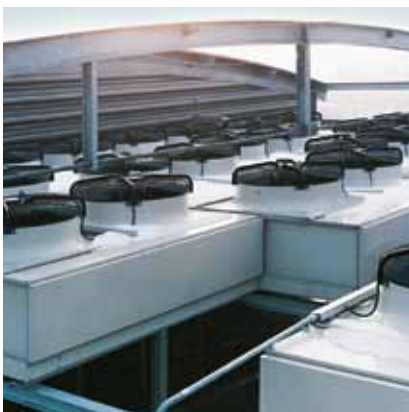
Kühlluftförderung durch Sichelventilatoren
