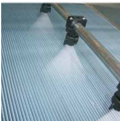
Sprühdüsen befeuchten den Wärmeaustauscher
