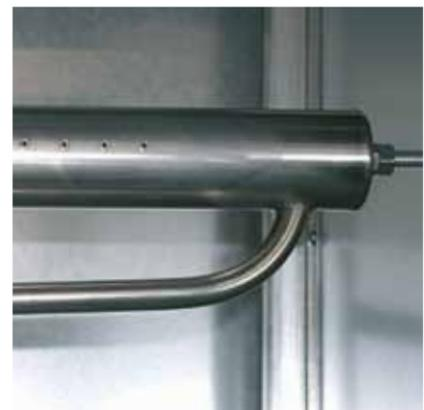
Dampfbefeuchterlanze mit Kondensatrohr
