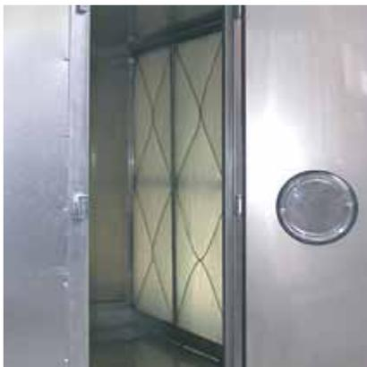
Tropfenabscheider für Hochdruckbefeuchter
