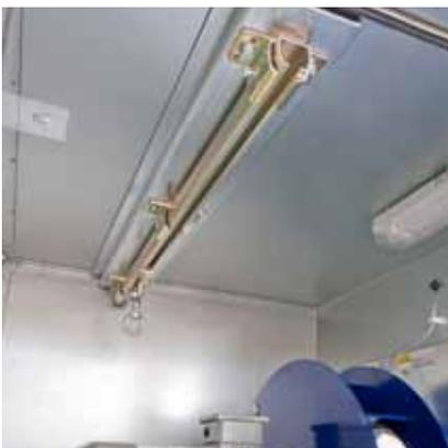
Auszugsschiene zum Ventilatortausch
